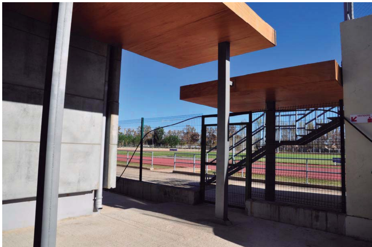
Accés a la pista d'atletisme des del vial intern de connexió entre la residència d'estudiants i la sala d'esgrima.
