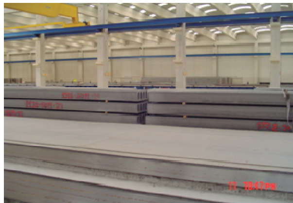
Acopio de Placas alveolares
